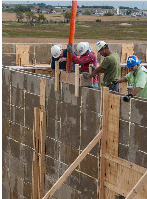
Figure 16b: Wall pour using kevlar sleeve and pour box.
